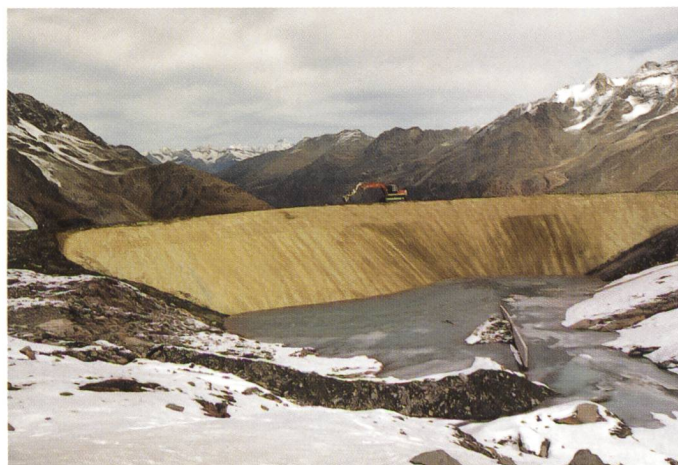
Bild 5. Abdichtung der wasserseitigen Dammböschung mit stabilisierter Bodenmischung beim Speicherbecken der Beschneigungsanlage am Othmarhang bei Saas Fee VS (Foto: A. Kobelt).
