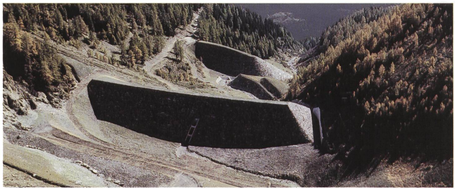
Bild 6. Lawinenauffangdämme im Val Varuna GR. Der oberliegende Damm (in Bildmitte) von 220 m Länge und 50 m Höhe weist eine zentrale Durchlassöffnung und am rechten Widerlager eine tief eingeschnittene Hochwasserentlastung auf. Der unterliegende Damm (oben rechts) besteht aus zwei sich überlappenden Halbdämmen, um die der Bach offen herumgeführt wird (Foto: Hegland + Partner AG, Chur).
