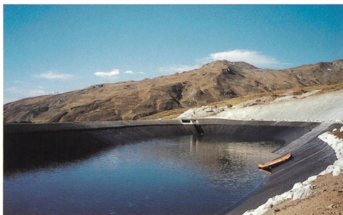
Bild 2. Abdichtung und Asphaltbeton. Speicherbecken Alp Dado GR während des Ersteinbaus. In Bildmitte sind das Einlaufbauwerk und die Hochwasserentlastung sichtbar. Rechts unten erscheint noch ein Stück der begrüneten Beckenumrandung, welche den obersten, über dem Wasserspiegel liegenden Böschungsabschnitt bildet (Foto: R. Müller).
