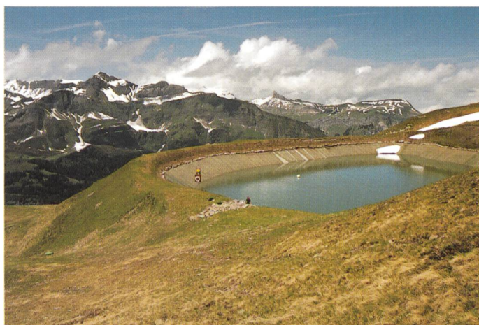
Bild 3. Speicherbecken der Beschneigungsanlage am Lauberhorn BE. Abdichtung der wasserseitigen Böschung mit einer Geomembrane (Foto: A. Kobelt).
