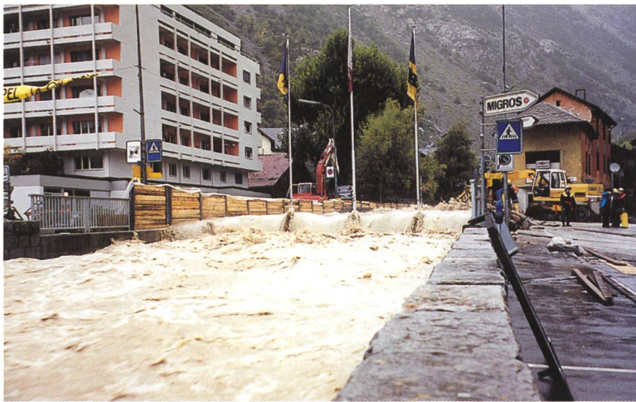
Bild 6. Mobile Elemente aus Stahlträgern und Dammbalken.
