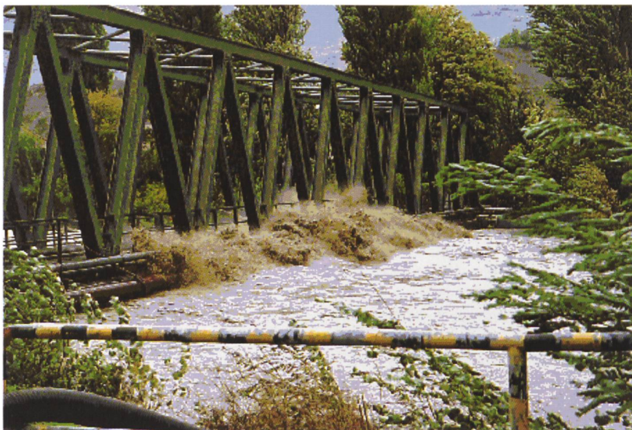
Bild 7. Auf Grund der verbreitet intensiven Niederschläge waren die Gerinne der Rhone und ihrer Zuflüsse auf der ganzen Länge bis an und teilweise über die Kapazitätsgrenze belastet, wie dieses Bild der Rhonebrücke bei Chippis eindrücklich belegt (Foto: Alusuisse ).
