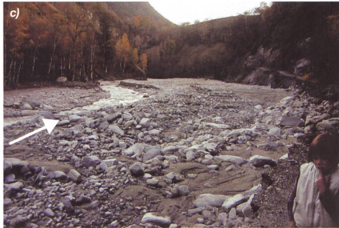
Bild 15. Obere Geschieberückhaltekommer im «Grindji: a) Zustand vor dem Hochwasser; b) während des Hochwassers vom 14./15. Oktober 2000; c) Auffüllung nach dem Hoch- wasser. (Fotos: André Burkard, Brig)
