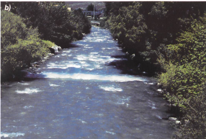
b) korrigierter Abschnitt mit Schwellen im Dorf;
