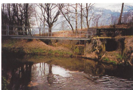
Bild 2. Durchlass Au mit Rechem Hintergraben.
