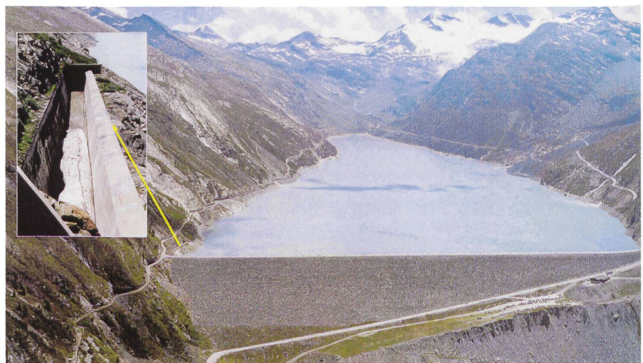
Bild 3. Stauanlage Mattmark mit Hochwasserentlastung. Nutzinhalt: 100 Mio. m 3 \Delta 331 GWh, max. Stauhöhe 2197 m ü.M.
