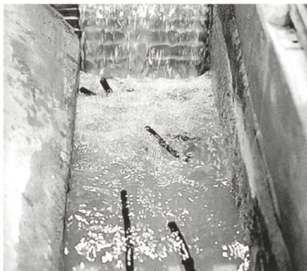
Bild 13. Schwemmholz im Tosbecken bei Q_z = 3,0 \text{ m}^3/\text{s} .
