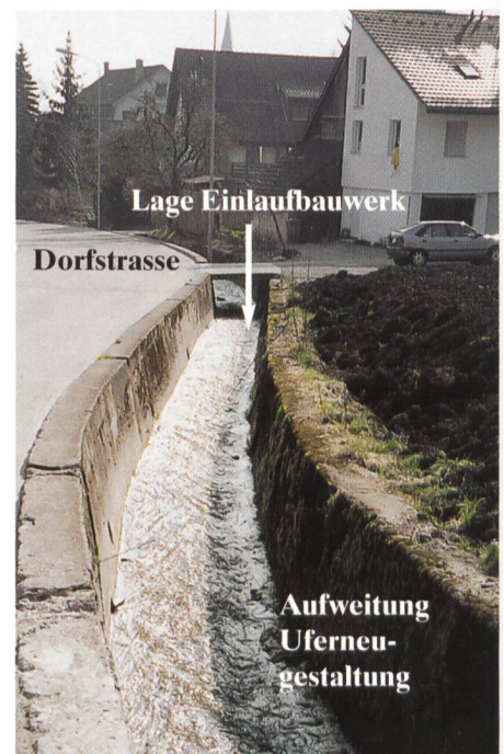
Bild 3. Blick in Fliessrichtung des Dorfbaches Spreitenbach im Ist-Zustand auf die künftige Lage des Einlaufbauwerkes. Im Zuge der hochwassersicheren Umgestaltung werden das Gewässer wo möglich aufgeweitet und die Ufer mit Böschungen und Bepflanzung naturnah gestaltet.
