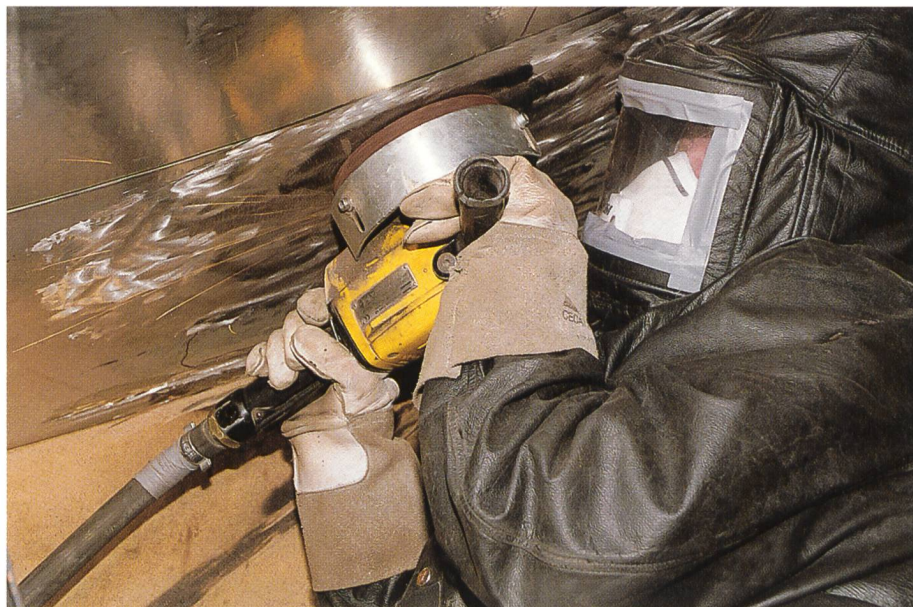
Bild 2. Die 4,5 kW Dauerleistung sieht man dem Turboschleifer nicht an. Besonders bei Über-Kopf-Arbeiten spielt das geringe Gewicht (4,3 kg mit Topfscheibe wie hier im Bild) eine grosse Rolle. Zum Vergleich: Ein Elektroschleifer wäre doppelt so schwer (Foto: Atlas Copco Tools).
