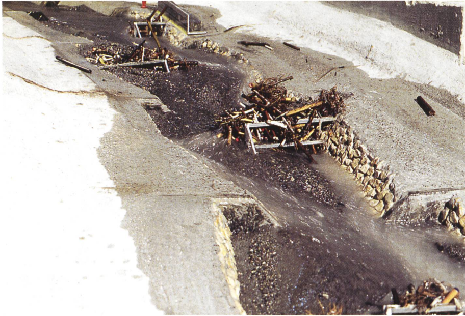
Bild 9. Anordnung mehrerer Bauwerke zum Rückhalt der Wurzelstöcke in der Sperrentreppe des Riemensaldnerbachs gegen Ende eines Versuchs für das Extremereignis.
