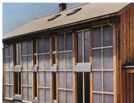
Bild 2. Das Gasthaus auf der Hundwiler Höhe wird mit Transparenter Wärmedämmung geheizt.
