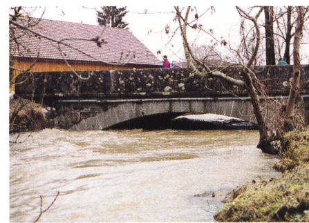
Bild 12. Brücke in Oberkulm bei einem mittleren Hochwasser.
