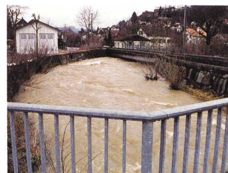
Bild 13. Blick auf die Brücke der Wynental-Suhrental-Bahn im Leerber in Gränichen.
