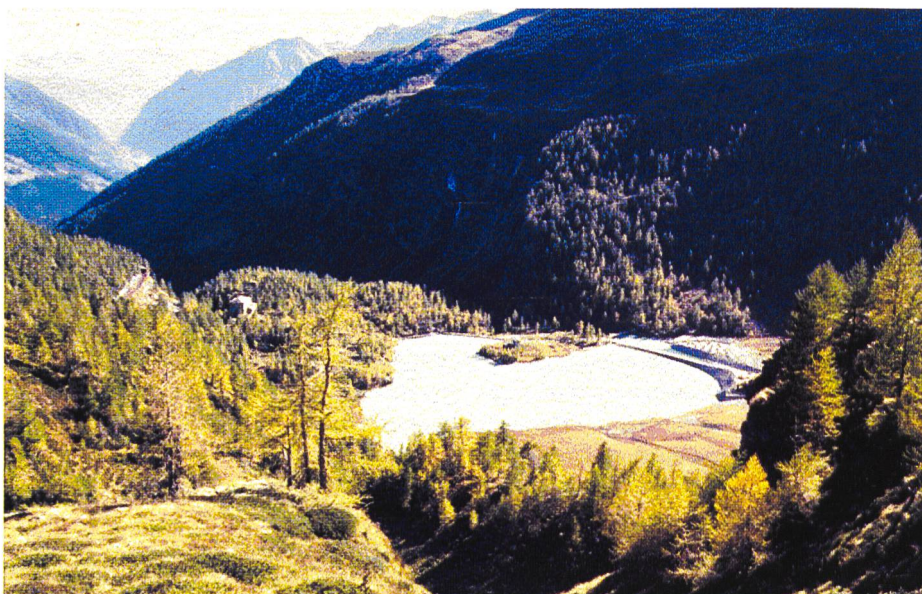
Bild 3. Speichersee des Kraftwerkes Palü.
