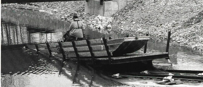
Boottransportanlage Flusskraftwerk Ruppoldingen
