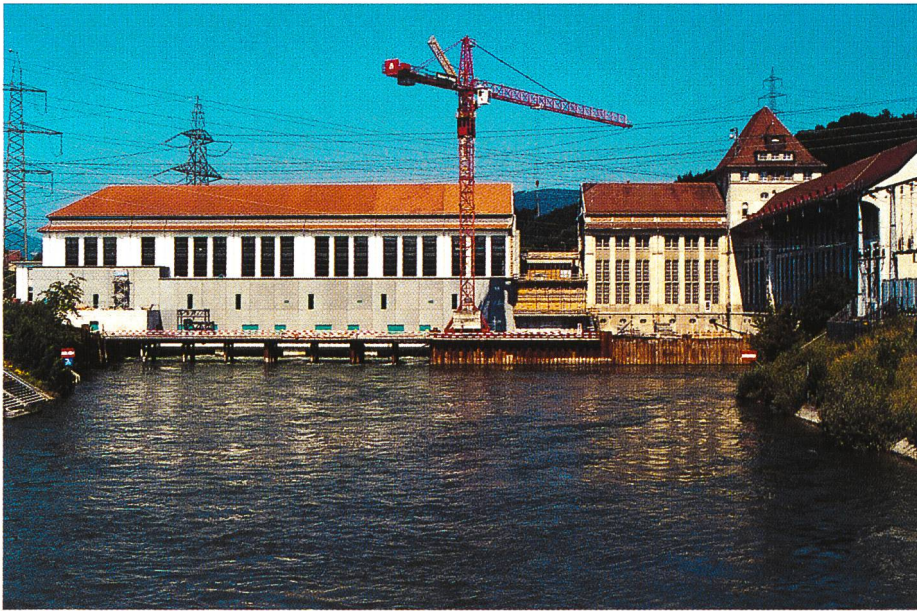
Bild B2-3. Blick auf die Unterwasserseite des Wasserkraftwerkes Gösgen während der 5. Bauetappe im Juli 2000. Das neu erstellte Maschinenhaus mit anschliessendem Vorbau zeigt deutlich die neuzeitlichen Nuancen der Architektur auf, im Gegensatz zu dem alten Gebäudeteil im Stile des Klassizismus auf der rechten Seite, welches aus Gründen des Denkmalschutzes erhalten wurde.
