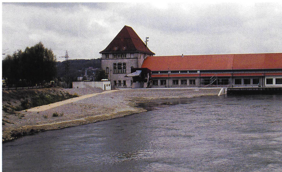
Bild B6-12. Gestaltung der linken Oberwasserschüttung nach Fertigstellung der Arbeiten. Die effektive Leitwand liegt unter dem Wasserspiegel und ist daher nicht ersichtlich.
