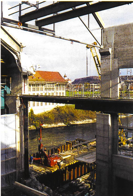
Bild B6-10. Montage der provisorischen Kranbahn.
