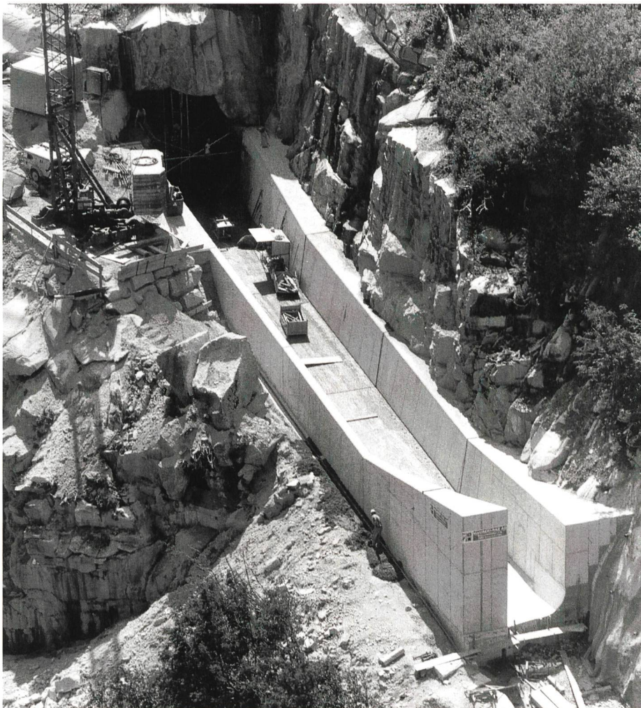
Bild 4. Die neue Wasserrückgabe in die Aare.
