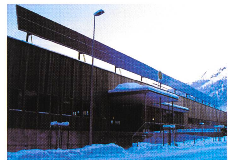
Bild 3. Die Solaranlage Eisarena Ludains, St. Moritz, wurde zur Erfüllung des Fördermodells erstellt.
