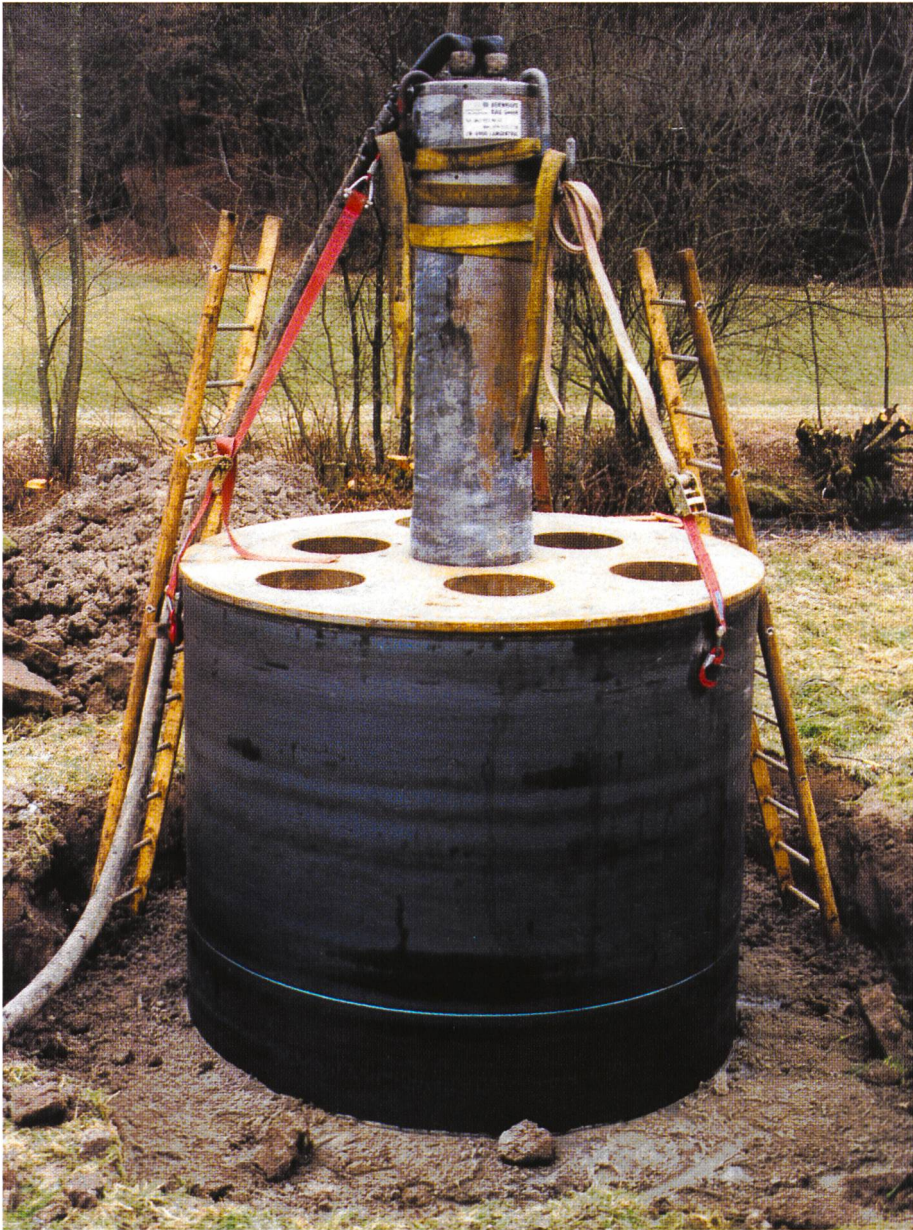
Bild 2. Der Terra-Hammer TR 540 rammt mit zwei bis drei Schlägen pro Sekunde und einer Schlagkraft von 2200 Tonnen das Rohr mit Ø 2,5 m Zentimeter für Zentimeter in das Erdreich.
