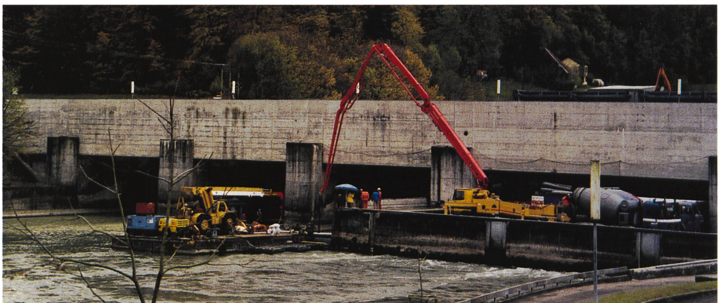
Bild 3. Die Betonierinstallationen im Unterwasser.
