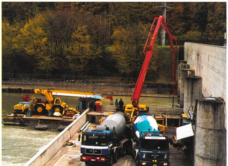
Bild 2. Während der Betonierarbeiten.
