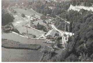
Barrage de la Maigrauge
