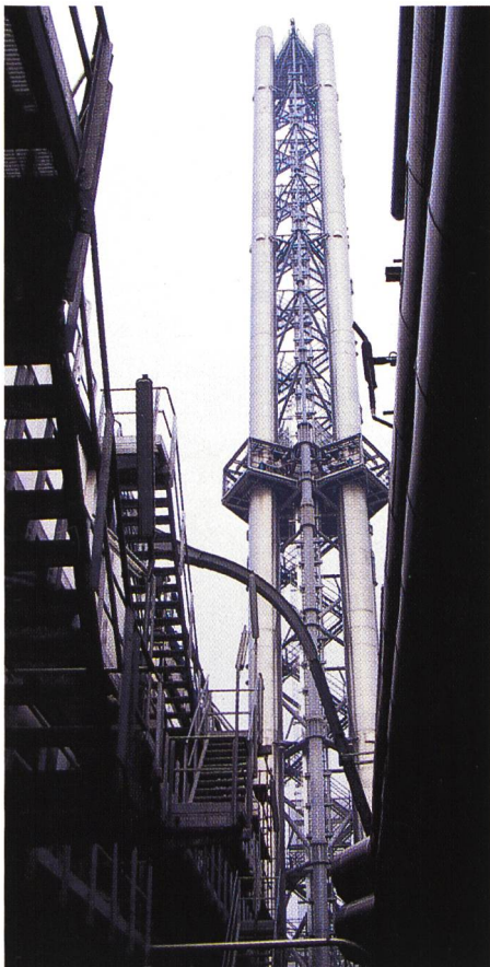
Bild 4. Rauchgasreinigung mit 80 m hohem Kamin.
