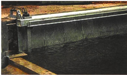
Bild 6. Horizontale Rechenreinigungsmaschine: Bei kleinen Rechen mit Abschwemmöglichkeit stellt diese eine einfache Gesamtlösung dar.
