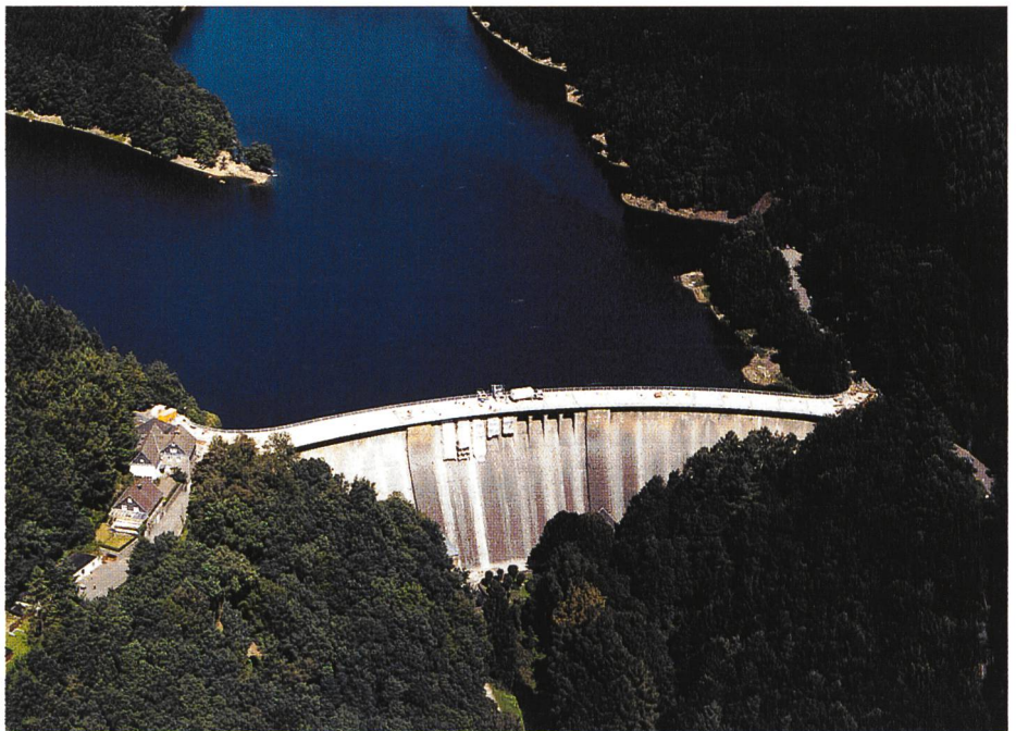
Bild 1. Auf ganzer Länge erneuerte Staumauerkrone der Aggertalsperre und die neun sanierten Überlaufbereiche in Staumauermitte. (Foto: Peiniger RöRo)
