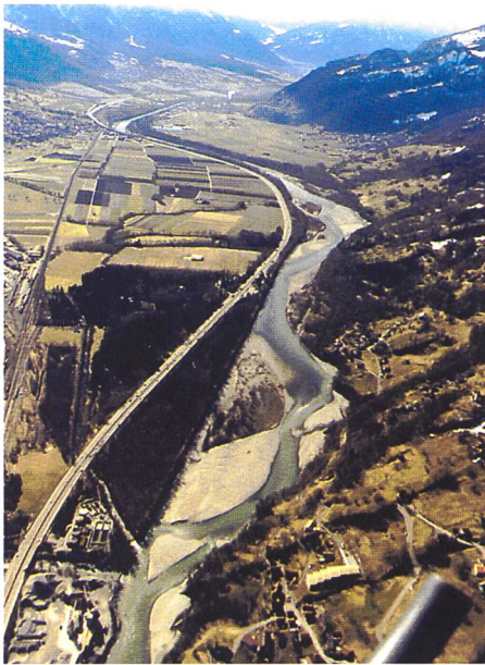
Bild 1. Rhein Zizers – Landquart mit den Mastriiser Rheinauen (Teststrecke Mastriis). Blick gegen die Flieβsrichtung.
