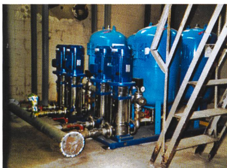
Das Trinkwasserreservoir mit Druckerhöhungsanlage konnte mit Unterstützung von Georg Fischer saniert werden.
