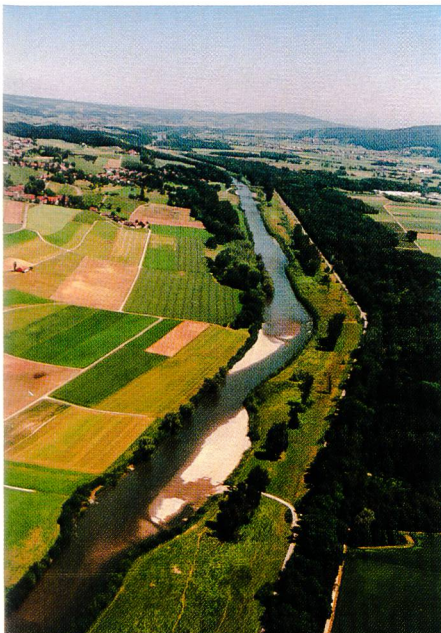
Bild 6. Abschnitt Ror-Uesslingen. Die neu gestaltete Thur oberhalb Uesslingen; Mittelgerinne mit Aufweitung und Kiesbänken.
