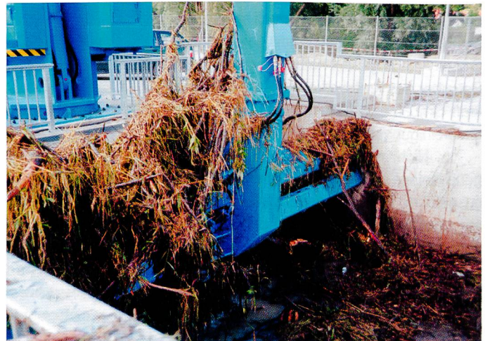
Bild 5. Greiferharke schliesst sich über der Wasseroberfläche.
