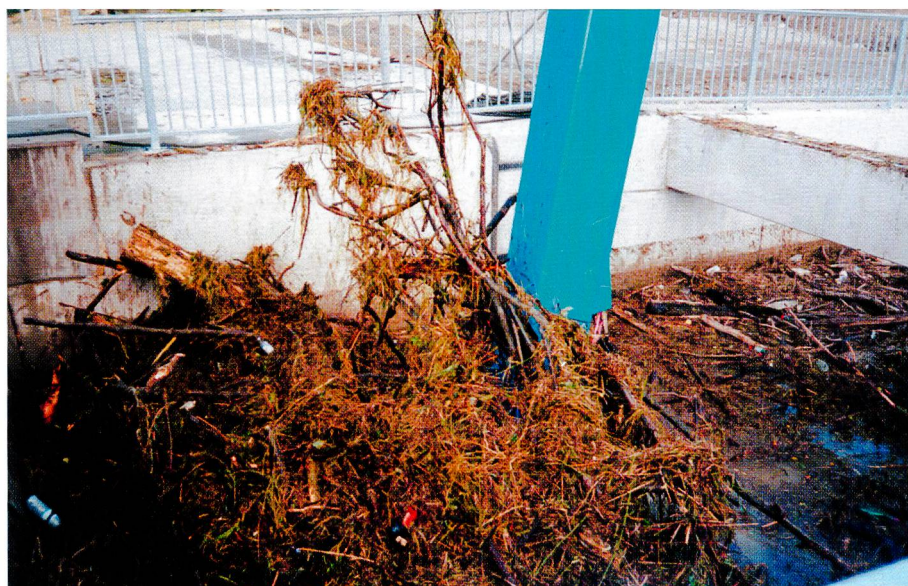
Bild 2. Harke knapp unter der Wasseroberfläche.
