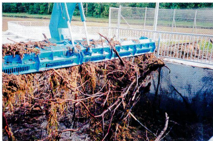
Bild 7. Geschlossene Harke mit Schwemmgut.
