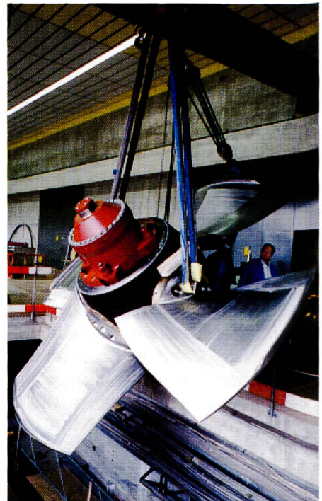
Bild 3. Neues Turbinenlaufrad bei der Montage.
