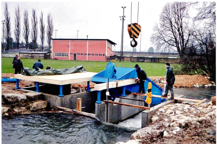
Bild 5. Das knapp über dem zukünftigen Oberwasserspiegel gehaltene Bauwerk ergibt eine lange Überfallkante.
