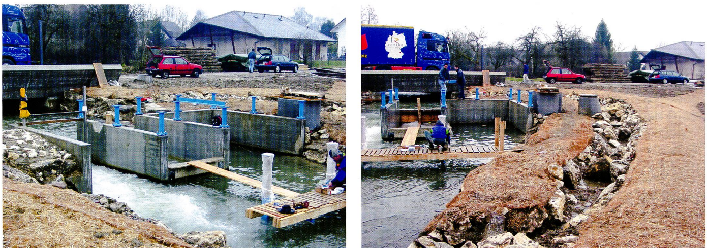
Bild 2. Das Kraftwerk: links der Umgehungs kanal, mittlerer Triebwasser kanal, rechts der Überlauf und die Fischtreppe. Der Aufstellungswinkel der Schnecke wird mit einer Holzlehre korrekt positioniert (Bild rechts).
