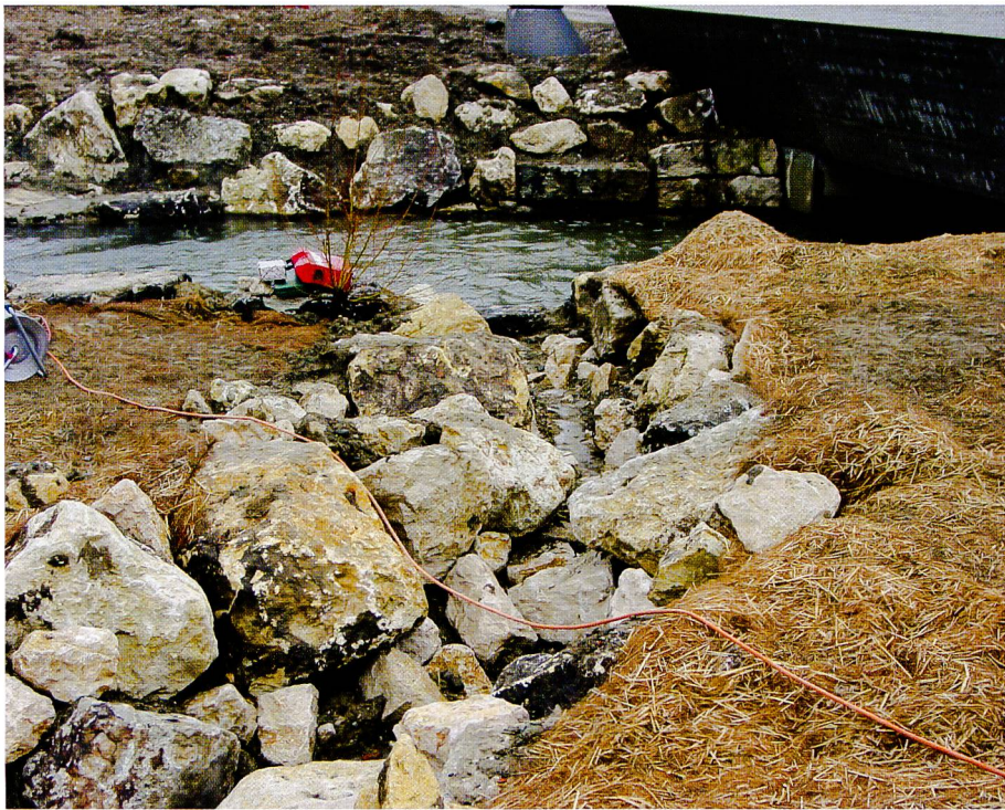
Bild 6. Der oberwasserseitige Ausstieg der Fischtreppe.
