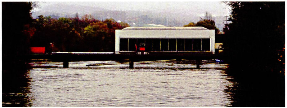
Bild 9. Maschinenhaus des KW Rüchlig. Im Vordergrund die Zufahrtsbrücke zum Kraftwerk (KW-Zufahrt). Blick in Fliessrichtung.
