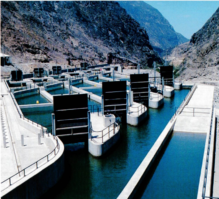
Bild 1. Typischer Langsandfang bestehend aus fünf parallel angeordneten, horizontal durchströmten Absetzbecken in Peru. Trotz unterschiedlicher Zuströmung sind die Becken identisch ausgelegt, was allenfalls problematisch sein könnte.
