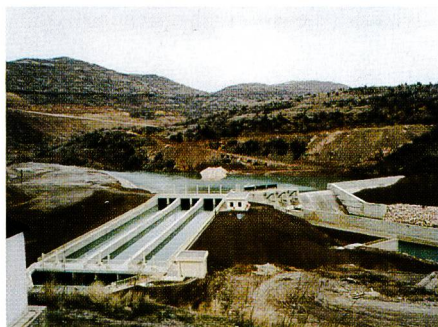
Bild 8. Wasserfassung KW Camlica I mit Stauwehr, Einlaufbauwerk, Entsander.
