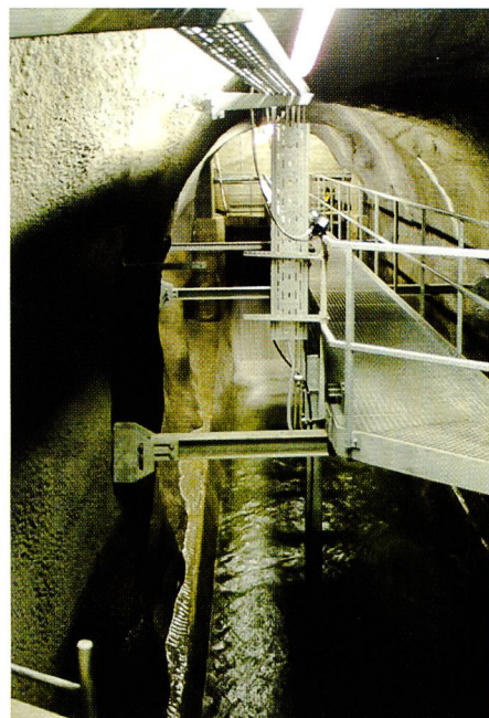
Bild 21. Entleerte Entsandkammer mit Sand-Abtastsonde (Typ Schwinger gabel).
