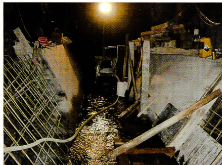
Bild 31. Spülkanal des Entsanders im Rohbau.
