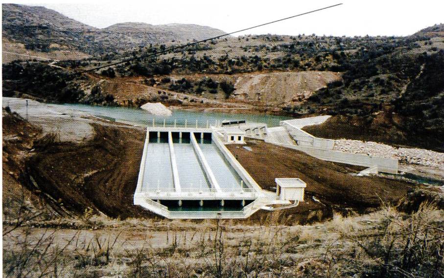
Bild 1. Wasserfassung und Entsanderanlage des Kraftwerkes Camlica I in der Türkei.
