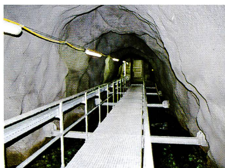
Bild 32. Entsanderkammer mit Bedienungsteg.
