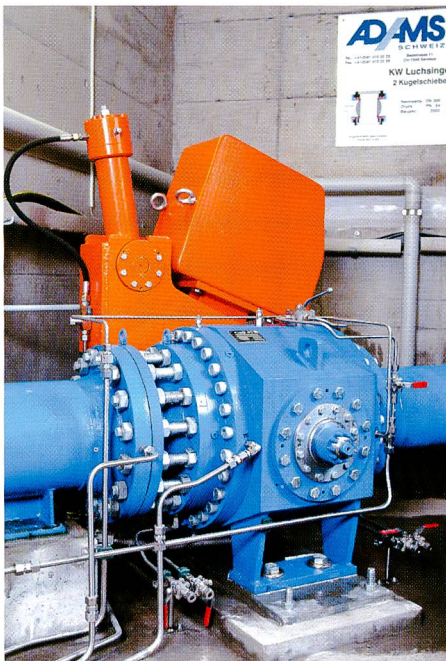
Kugelschieber für Turbinenanschluss Saracinesca a sfera per allacciamento turbina Armature sphérique pour raccordement turbine
