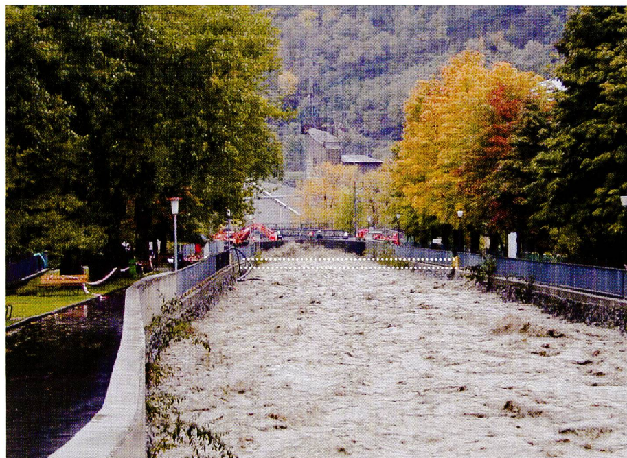
Bild 12. Blick in Fließrichtung in den Unterlauf des Saltinakanals auf der Höhe des Spitals. Die Stelle, wo der Fussgängersteg abgebrochen wurde, ist mit einer unterbrochenen weissen Linie markiert. Der Abfluss staute sich zweitweise und leicht an der verschalteten Festungswachtbrücke (Foto A. B.).
