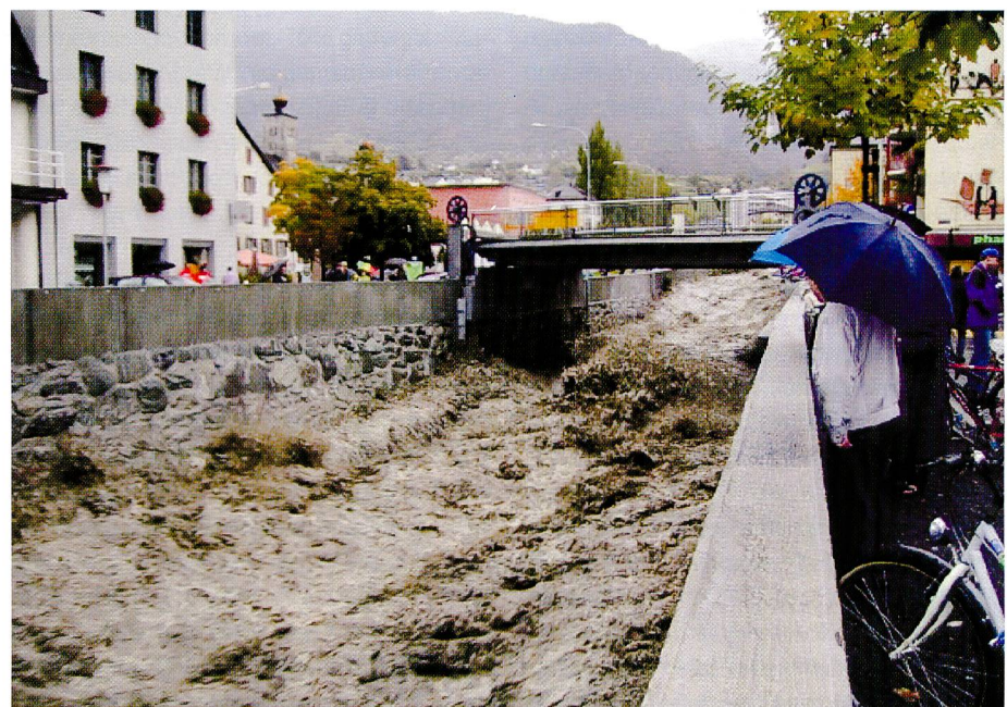
Bild 10. Angehobene Hubbrücke über die Saltina. Sonntagvormittag, 15. Oktober 2000 (Foto St. Walther, Brig-Glis).
