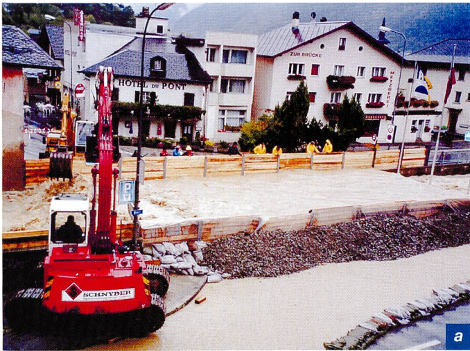
Bild 3, a und b. Verhinderung eines seitlichen Ausfliessens der Lonza an der Dorfbrücke Steg-Gampel mit mobilen Dammbalken anlässlich des Hochwassers vom 14./15. Oktober 2000.
