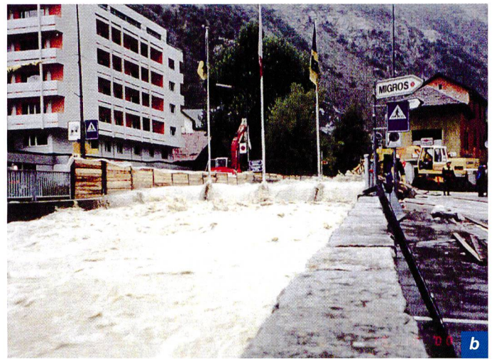
Bild 3, a und b. Verhinderung eines seitlichen Ausfliessens der Lonza an der Dorfbrücke Steg-Gampel mit mobilen Dammbalken anlässlich des Hochwassers vom 14./15. Oktober 2000.
