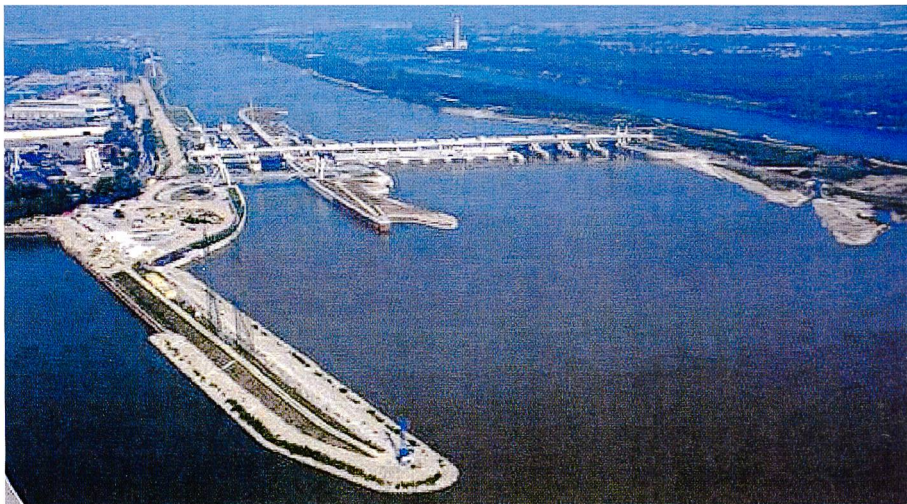
Bild 2. Donaukraftwerk Freudenua; ein Kraftwerk im grossstädtischen Bereich.
