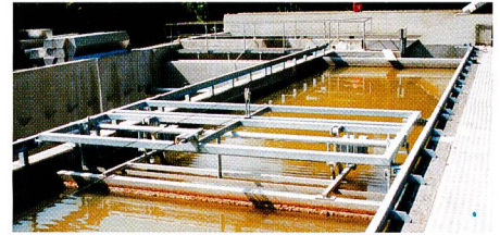
Bild 1. Roshard-Seilzugschleppräumer sind leichter, betriebssicherer und günstiger als konventionelle Brückenräumer.
