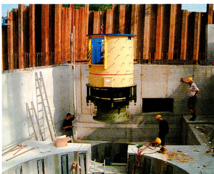
Bild 7. Montage Dotierturbine als Compacteinheit.
