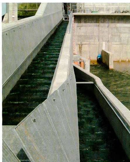
Bild 11. Betriebszustand mit 200 l/s Abflussmenge.
