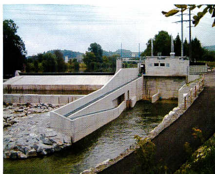
Bild 9. Ansicht von Unterwasser mit Fischaufstieg.
