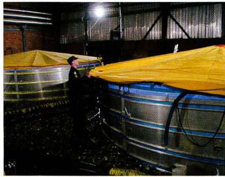
Bild 3. Die Lagerbecken zur Zwischenlagerung des Frischwassers.
