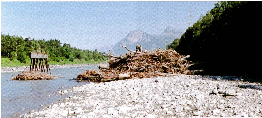
Bild 16. Teilverklausung des Alpenrheins bei alten Brückenpfeilern in der Bündner Herrschaft.
