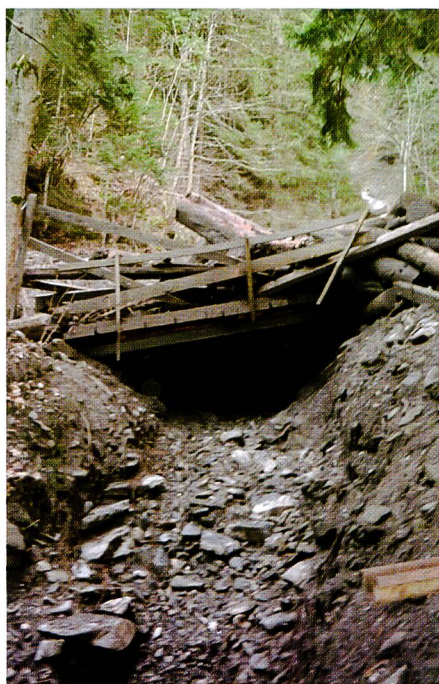
Bild 14. Beim Ereignis vom 15. bis 17. November 2002 verklauten zahlreiche Brücken über Wildbäche in den Emser Maiensässen, teilweise nur durch Geschiebe (links) oder durch Holz und Geschiebe (rechts).
