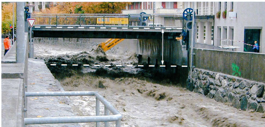
Bild 2. Entschärfung eines kritischen Querschnitts durch Anheben der Brücke im Hochwasserfall; Hubbrücke an der Saltina in Brig-Glis während des Hochwassers vom Oktober 2000 (Foto: A. Burkard, Brig-Glis).
