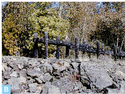
Figure 3. Exemple de structures destinées à piéger le bois et limiter son déplacement aval ou au sein du lit majeur. A. pioux installés dans un lit d'inondation localisé dans une section concave, prairial, surbaissé, qui sont destinés à retenir les bois avant qu'ils ne traversent la section urbaine de Bourgoin Jallieu (France). B. Barrière de bois réalisée sur la rivière Willamette (amont de Corvallis, Orégon), surmontant une protection de berge en enrochement et destinée à piéger les corps flottants avant qu'ils ne pénètrent dans des plantations forestières localisées en zone inondable.
