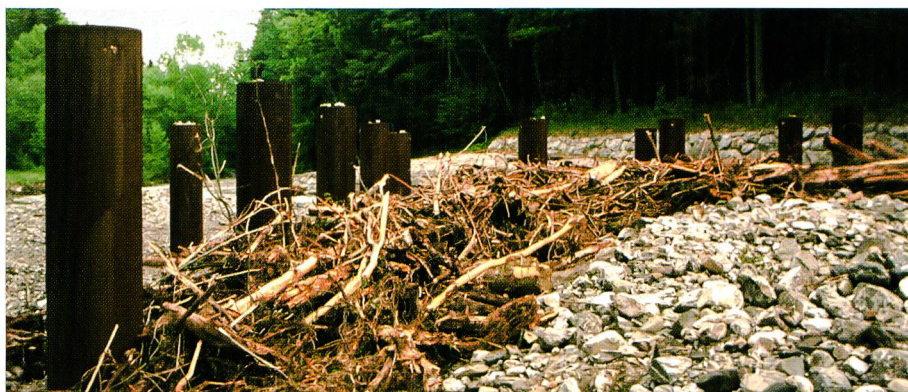
Bild 4. Mit Holz und Geschiebe verlegter V-Rechen am Lainbach (Oberbayern) nach einem Hochwasser; Blick in Fliessrichtung (Foto: Versuchsanstalt für Wasserbau und Wasserwirtschaft der TU München, Oberrach).
