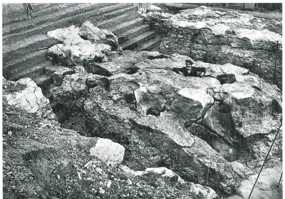
Bild 6. Felsenuntergrund des KW Gösgen während der Bauzeit.
