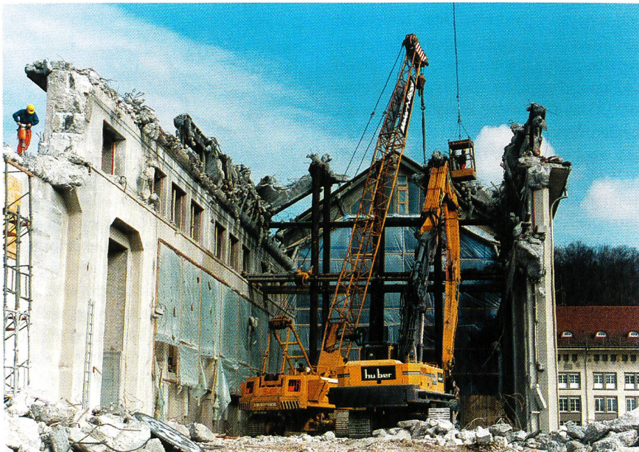
Bild 4. Abbrucharbeiten für den Umbau des KW Gösgen.
