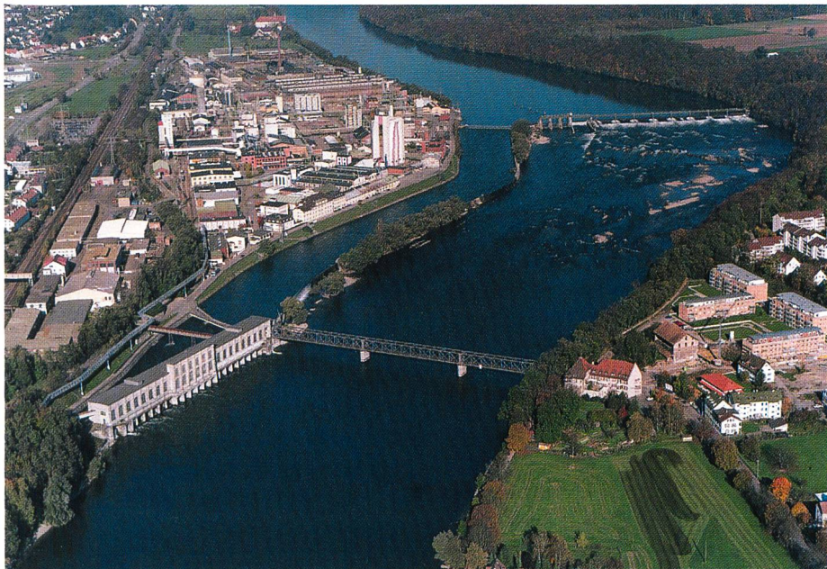
Bild 1. Luftbild des heutigen Kraftwerks Rheinfelden.
