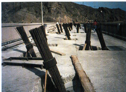
Bild 4. Horizontalrisse entlang den Arbeitsfugen im oberen Bereich der Sefid-Rud-Pfeilerkopfmauer, die 1990 während des Magnitude-7,7-Manjil-Erdbebens im Nordwesten Irans entstanden. Die Risse wurden mit Epoxymörtel ausinjiziert, und durch Vertikalvorspannung wurde die Scherfestigkeit verbessert.
