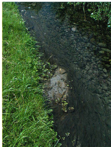
Bild 3. Sandauswaschungen in Drainagegräben – dank visueller Kontrolle entdeckt.
