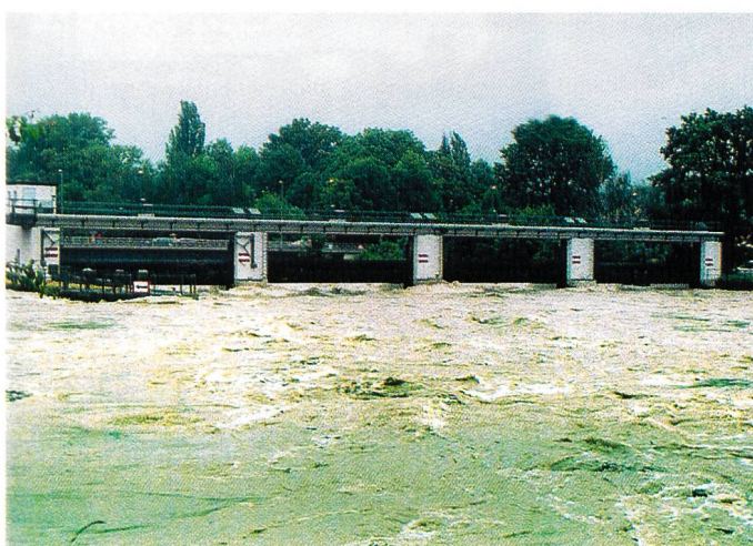
Bild 12. Abflusssituation an Pfingsten 1999, freier Wehrdurchfluss von 520 m 3 /s. Links: Blick in Strömungsrichtung. In Bildmitte ist die Scherzone schwach zu erkennen. Rechts: Blick flussaufwärts. Aufgrund der starken Wirbelbildung wirken grosse hydromechanische Belastungen auf den Untergrund ein (Bildquelle: Edy Toscano AG).
