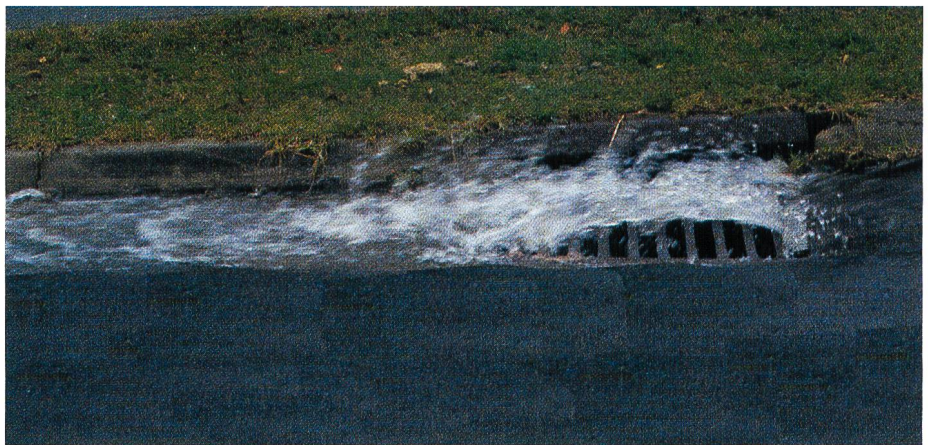
Bild 10. Auf steilen Strassen werden Kanalisationseinläufe oft überschossen, sofern die Fliessgeschwindigkeit entsprechend hoch ist.
