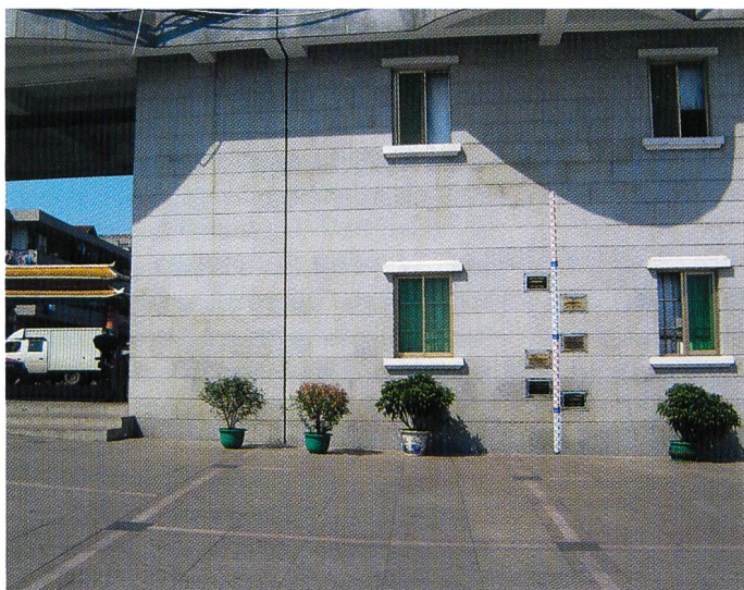
Bild 2. Nach dem Ereignis 1998 neu geschaffene überflutbare Uferzone im Stadtbereich Wuhan. Zu beachten: Hochwassermarken.
