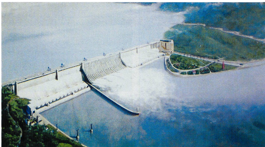
Bild 3. Übersichtsbild der Bauwerke.
