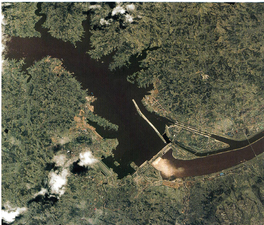
Bild 4. Satellitenaufnahme der Sperrstelle (MFB-Geoconsulting/DigitalGlobe, 2003).
