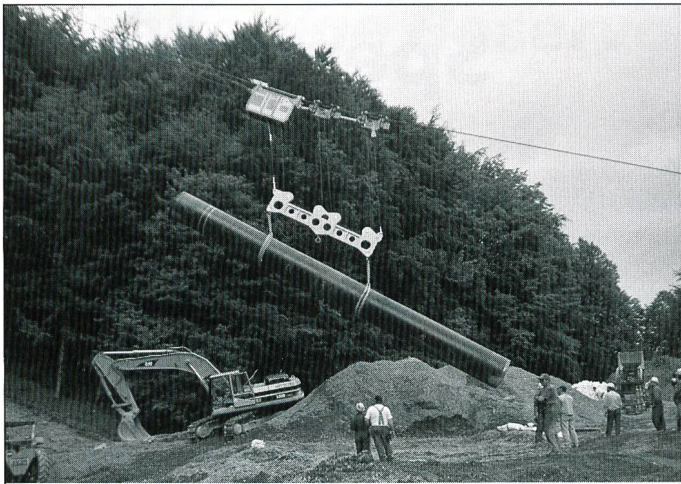
Transport und Versetzen Erdgasleitung, Rohrgewicht 12 Tonnen
