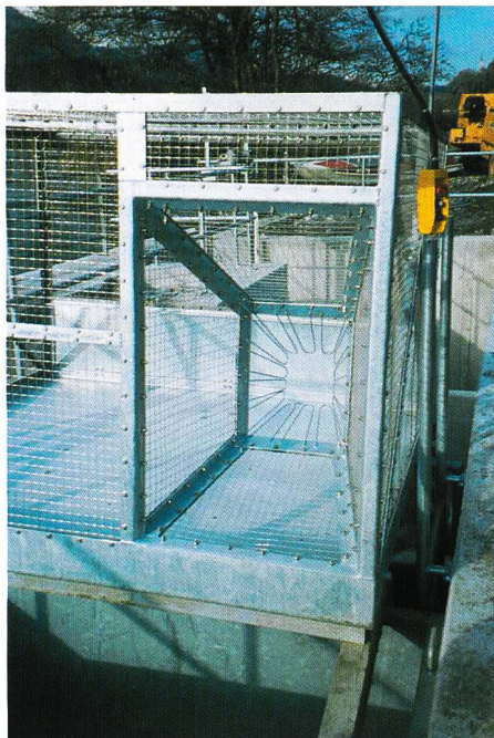
Bild 10. Heben der Reuse in der Fischpassanlage beim Kraftwerk Reichenau.
